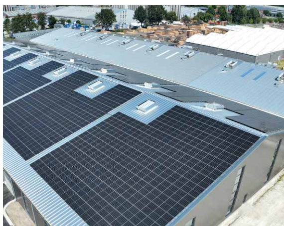
Neue Halle am Industrial-Standort in Haren/Deutschland: PV-Anlage mit einer Leistung von einem Megawatt Peak.
