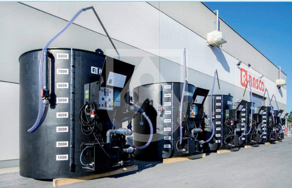
Mischbehälter für Liquid-Streufahrzeuge: Mit moderner Technik wird eine Salzlösung auf Basis von Natriumchlorid (NaCl), Calciumchlorid (CaCl 2 ) oder Urea hergestellt
