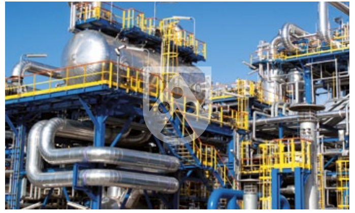
Chemischer Anlagenbau Chemical plants
