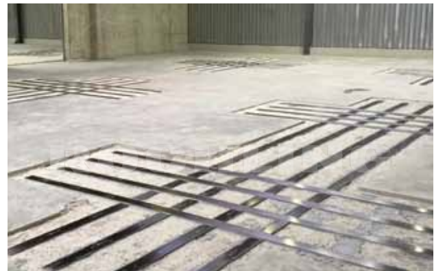
Verstärkung der Stützstruktur Supporting structure reinforcement Renforcement de la structure de support
