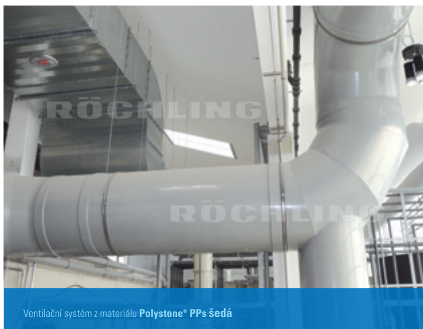
Polystone® P homopolymer šedá Větrací systém pro galvanizační zařízení
